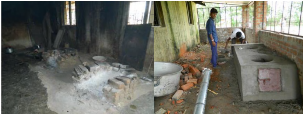
学校給食を作るための旧式コンロ（左） 学校用の大型改良型コンロを設置中（右。取付前の煙突が横たわる。）
