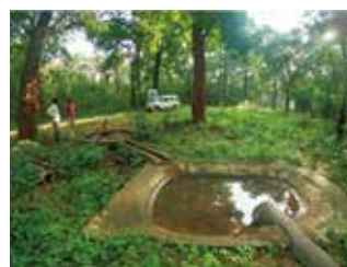
ソーラー式ポンプに接続された導管と池
